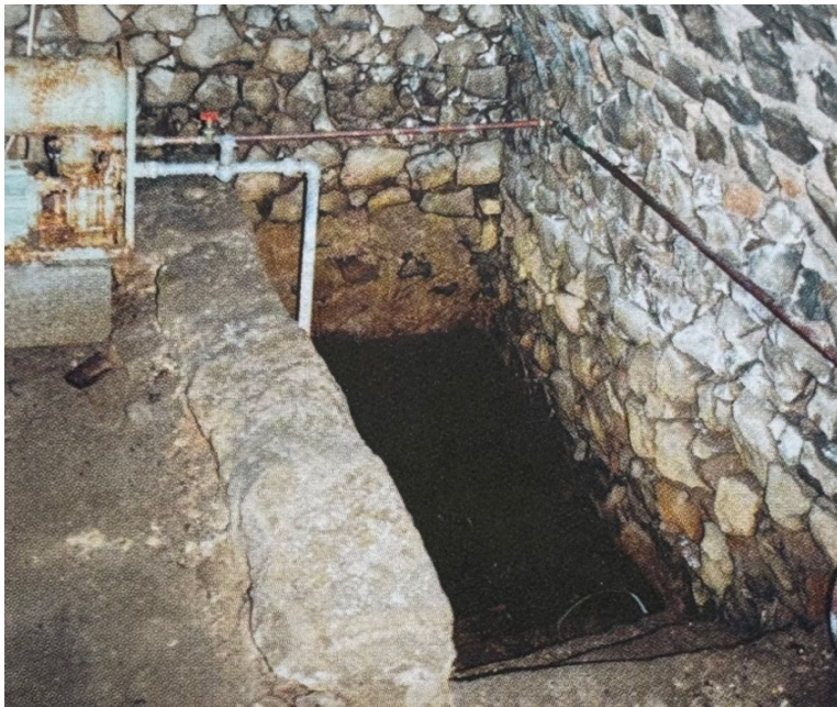
Tauchbecken der ehemaligen Mikwe in Felsberg.
